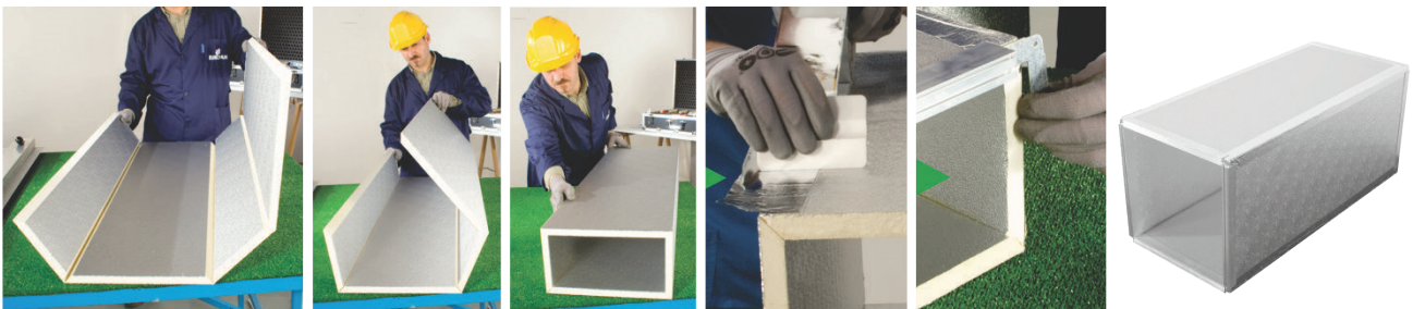
Exemple de réalisation d'une gaine :
