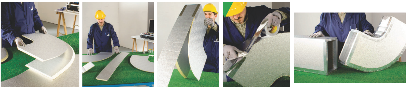
Exemple de réalisation d'un coude à 90° :
