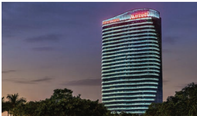
Lieu : Foshan - Chine Équipements installés : Ventilo-convecteurs
