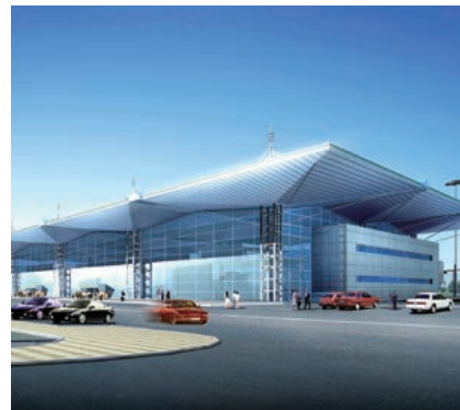
Lieu : Maputo - Mozambique Unités intérieures : VRF V4+
