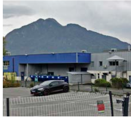
Lieu : Marnaz Équipements installés : VRF, Gainables, Centralisée
