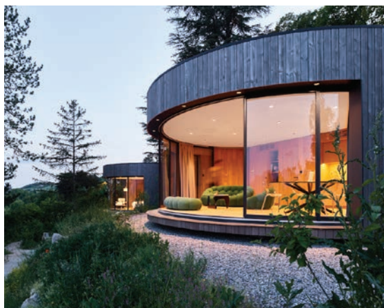
Installateur / Bureau étude / Maître d'oeuvre / Maître ouvrage : LumiPod Crédit Photo : LumiPod Par Lumicene® - ©KevinDolmaire
